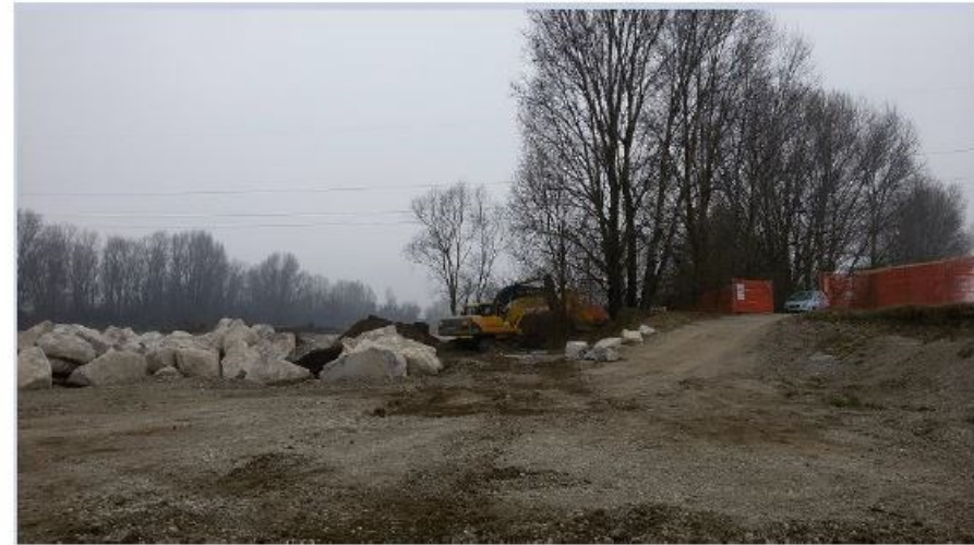
CANTIERE – PRIME FASI DI AVVIO – FEBBRAIO 2017
