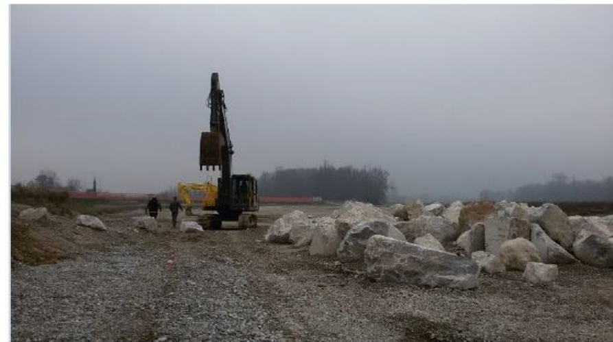
PRIME FASI DI COLLOCAZIONE DEI MASSI CICLOPICI IN SPONDA SINISTRA
