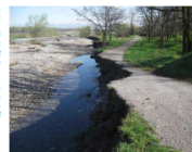
Foto 1 - Il fiume nel tratto fra Romano di Lombardia e Mantegna. Evidenza l'azione erosiva al piede della sponda che ha compromesso una infrastruttura per la fruizione pubblica.
